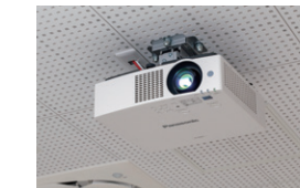
▲6,200 lmの光出力で100型スクリーンへ投写する小教室のPT-VMZ61J
