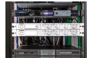
▲ワイヤレス受信機WX-SR204Aと増設ワイヤレス受信機WX-SE200A
